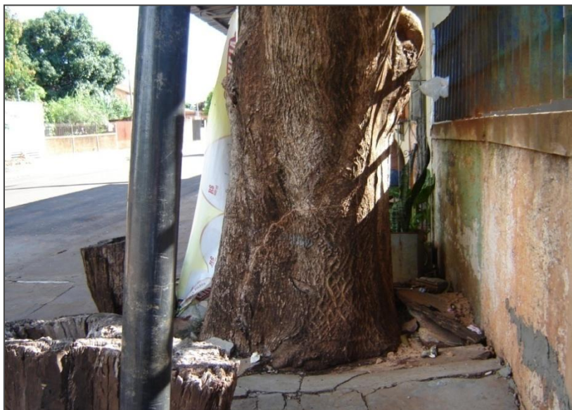
Figura 22. Exemplo de afloramento radicular gerando conflito com o passeio em área urbana de Campo Grande, MS. Foto: Mara Cristina Teixeira (nov/2009).
