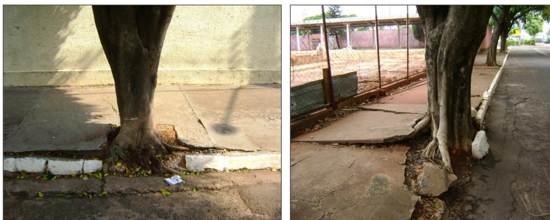
Figura 13. Espécie de Ficus e Sombreiro, respectivamente, causando danos à calçada e meio-fio. Fotos: Alessandra Ribas Buch (dez/2009).
